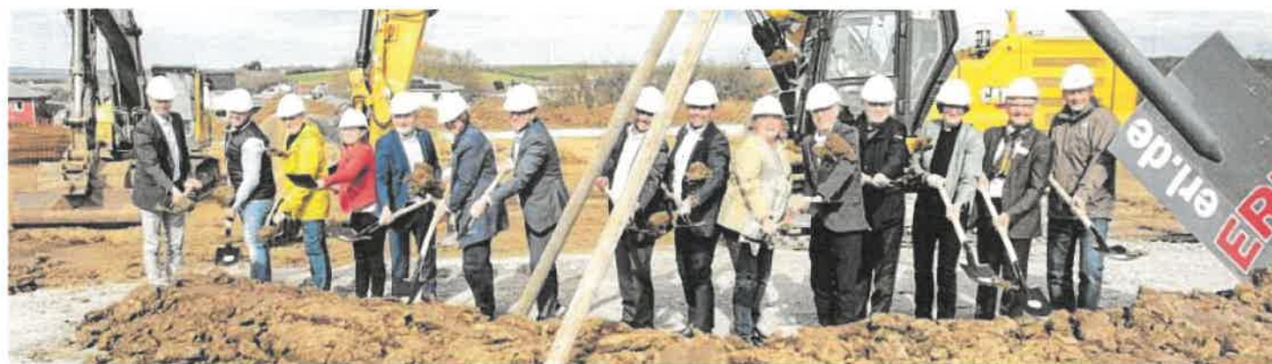
Mit dem Spatenstich am Donnerstag wurde der nächste Schritt zum Bau einer Pflegeeinrichtung in Marktbreit getan. Foto: Robert Haas
